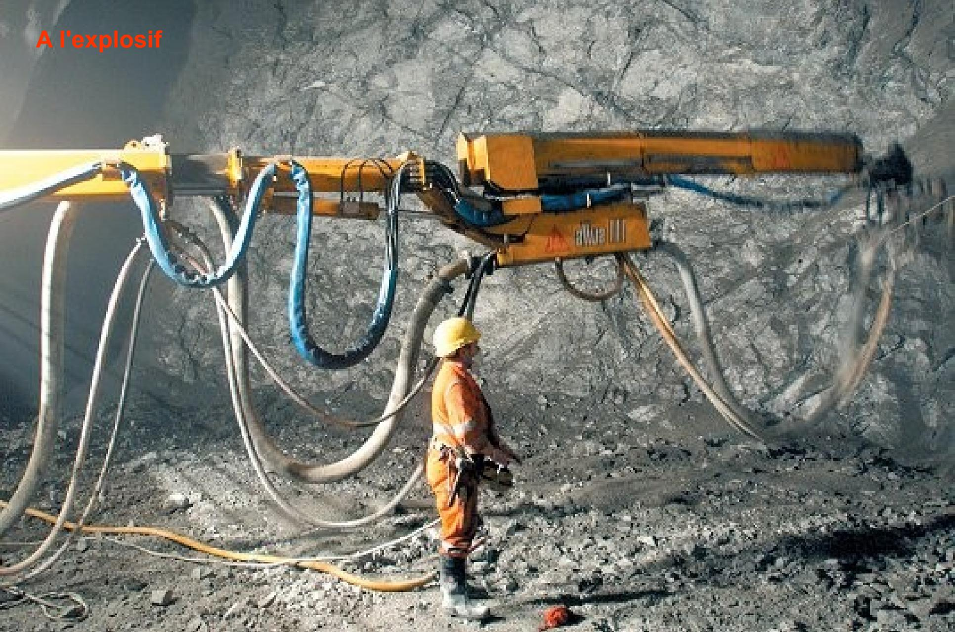
**Lorsque le tunnelier atteint un obstacle géologique, on doit recourir à l'explosif ou aux "jumbos" : ces engins sont équipés de plusieurs affûts de perçage et peuvent forer jusqu'à 4 trous simultanément. Mais là où le tunnelier progresse de 20 m par jour; l'explosif ne dépasse pas 6 à 9 m.**
