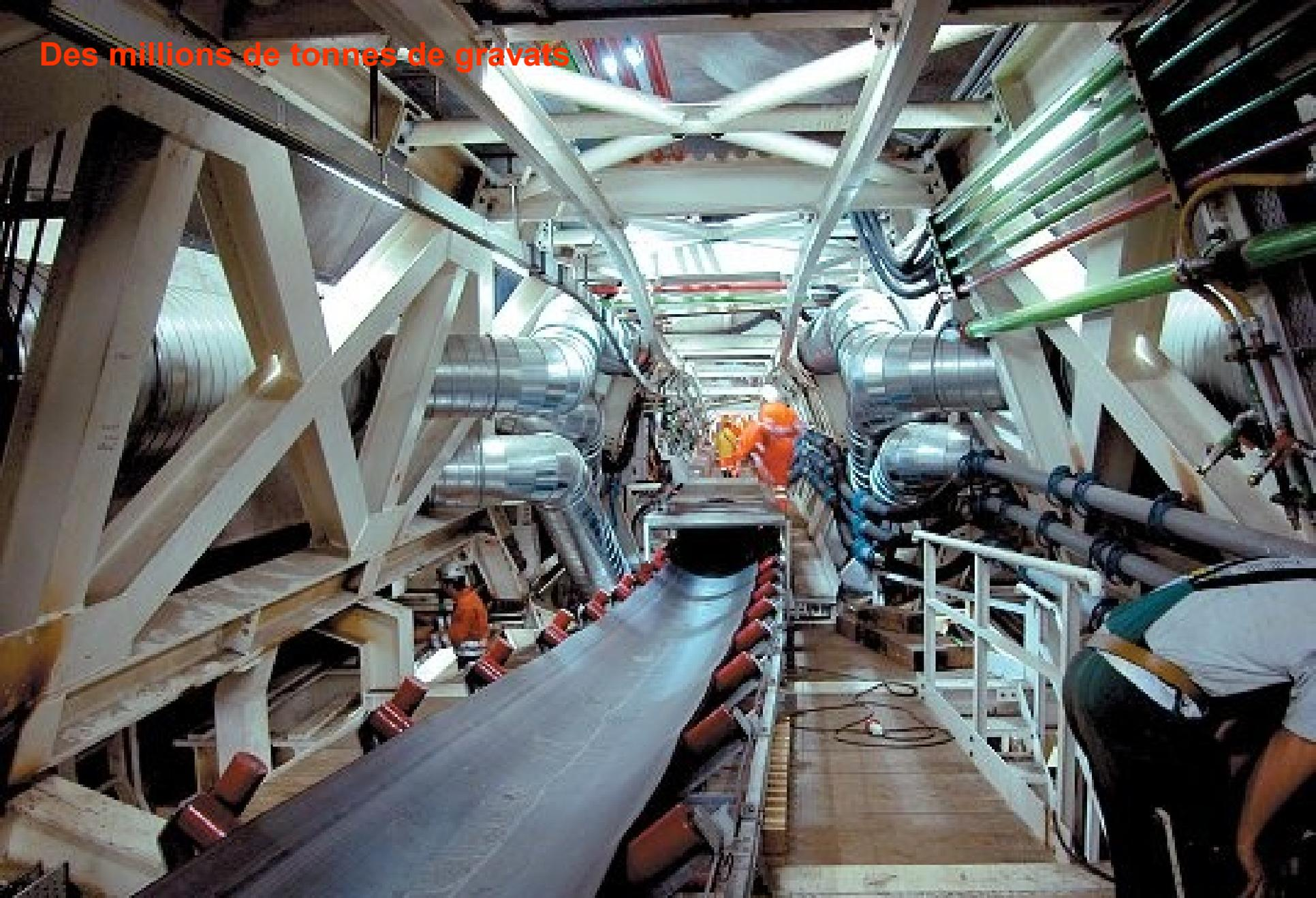
Des tapis roulants de plusieurs dizaines de km évacuent les déblais au fur et à mesure de l'avancée du tunnel. 24 millions de tonnes de gravier ont ainsi été extraits pour le seul tunnel de base.
