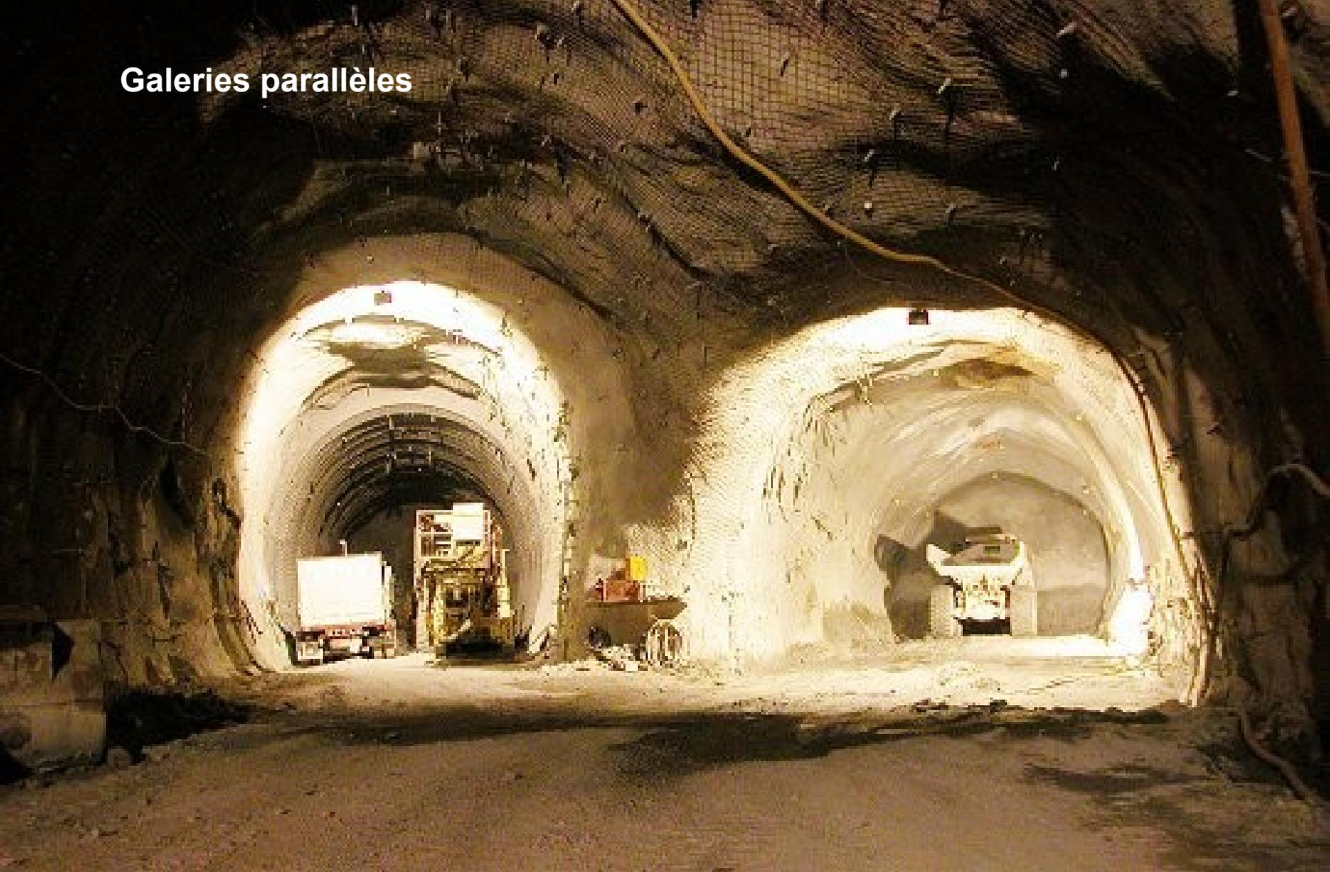
**Le tunnel se compose de deux galeries parallèles, reliées par 175 rameaux de communication, soit un, tous les 312 m. De puissants ventilateurs y sont installés : ils permettent d'évacuer la poussière et les substances nocives libérées lors des travaux**
