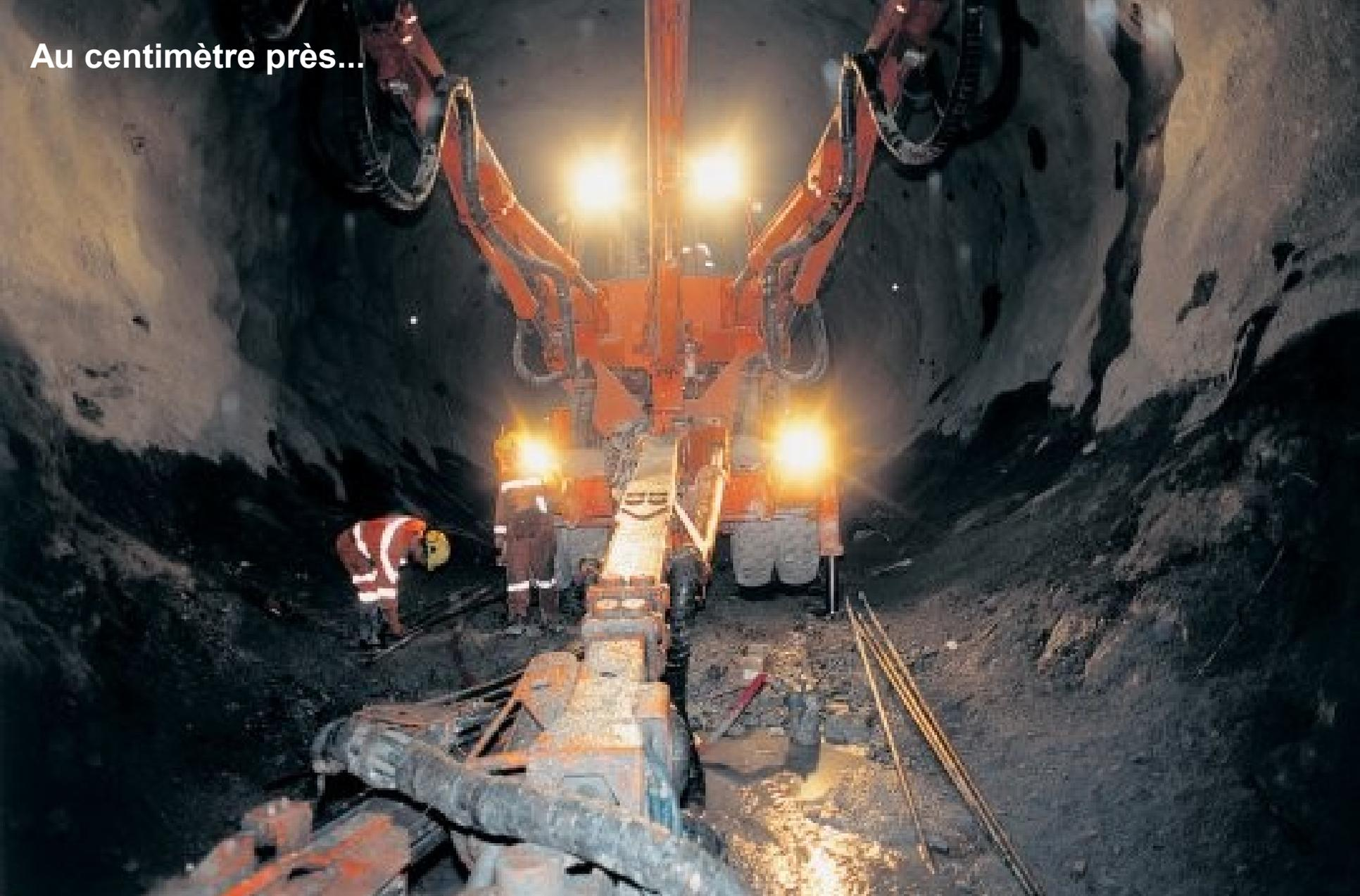
**Les ingénieurs n'ont pas droit à l'erreur pour le raccordement des 2 bouts du tunnel : la liaison entre les 2 est réalisée au centimètre près ! Les topographes ont travaillé avec des satellites et des ordinateurs. Ils ont dû tenir compte du soulèvement des Alpes qui est d'environ 1 mm par an**
