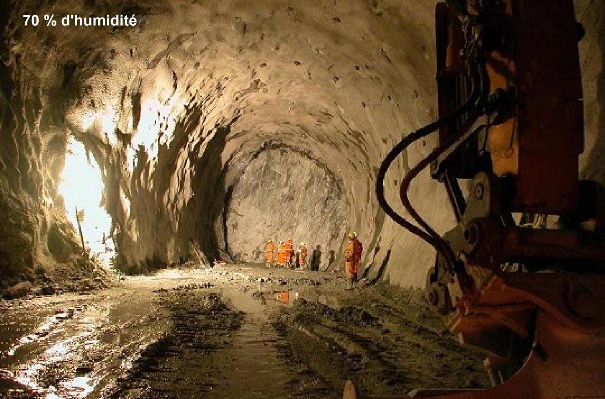
**L'humidité de l'air dans le tunnel est de 70 % ... 125 000 litres d'eau s'infiltrent par les parois du tunnel en un an. Elle est drainée hors du tunnel, puis refroidie dans des bassins de décantation avant d'être rejetée dans les cours d'eau les plus proches.**
