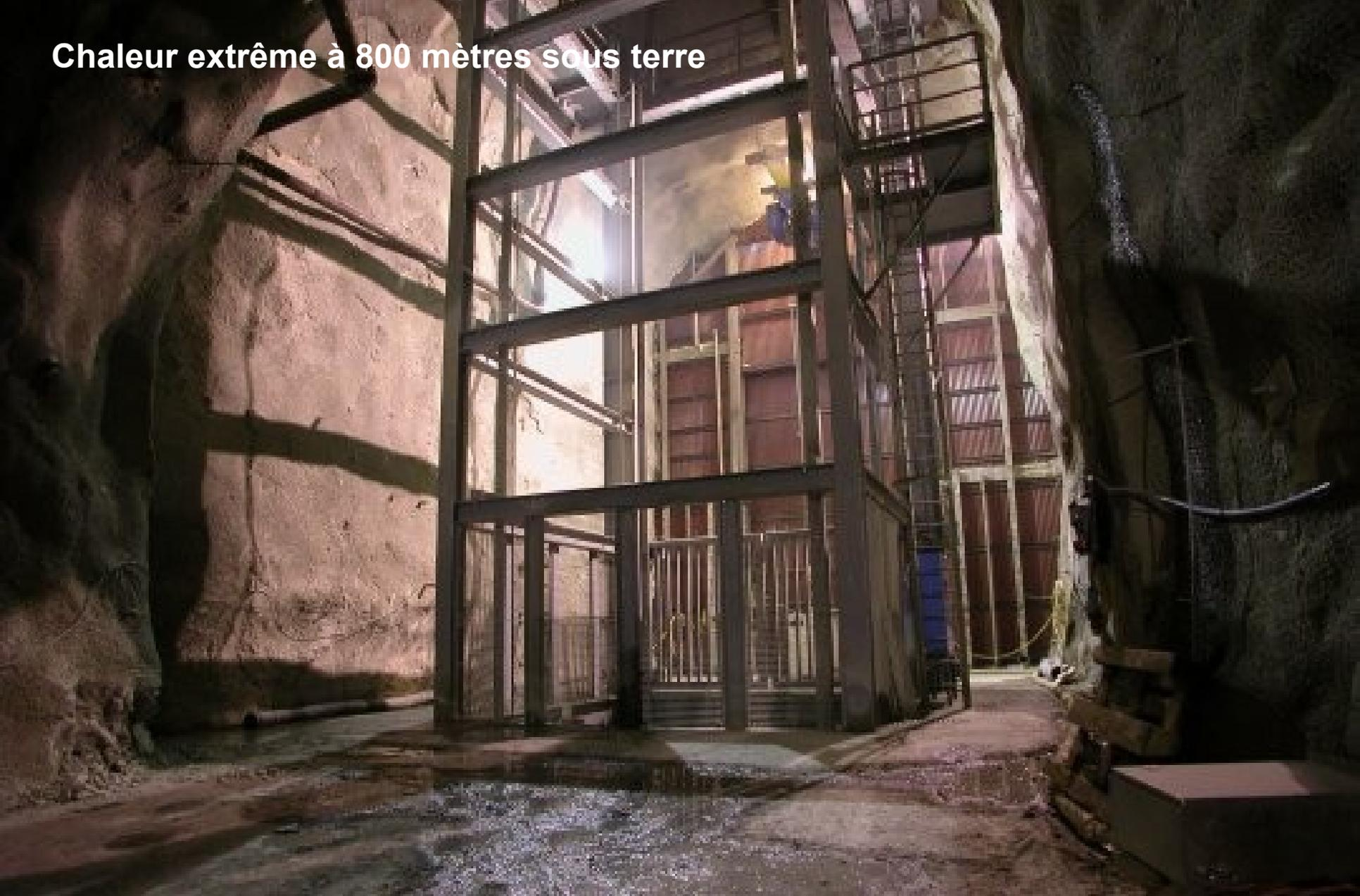
**Le puits d'accès descend à 800 mètres. A cette profondeur, la température de la roche atteint 45°C. De plus, les machines dégagent aussi de la chaleur, et les conditions de travail seraient insoutenables sans un système de refroidissement. La température moyenne est ainsi abaissée jusqu'à 28°C.**
